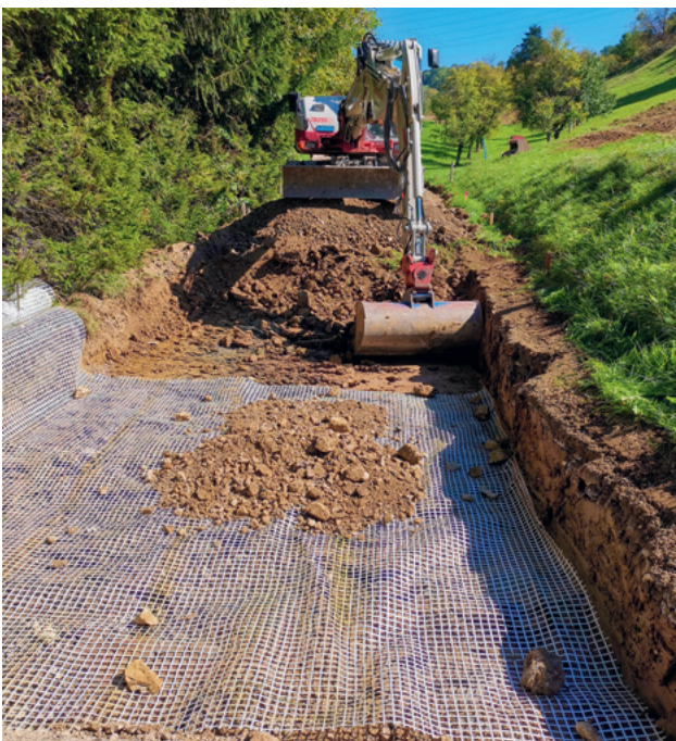
Strassenbauarbeiten durch das Gemeindewerk.
